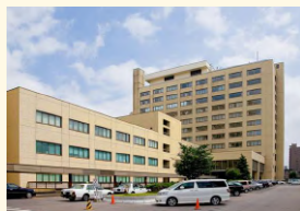
札幌医科大学付属病院 札幌市中央区南1条西16丁目291 内科、救急科、外科、小児科 産婦人科、精神科、選択科目
